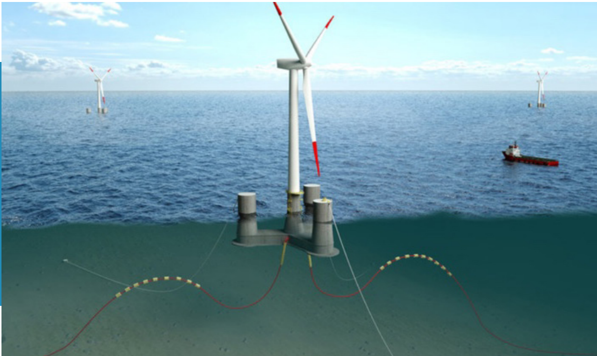
Aerogenerador offshore flotante. Fuente: Flagship Project 19
